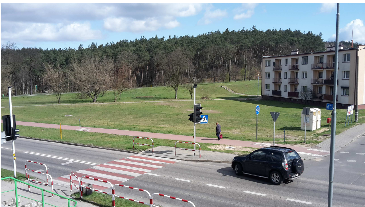
WIDOK OD STRONY ULICY POZNAŃSKIEJ
