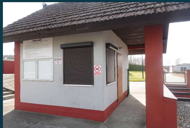
wyremontowano również budynek kasy
