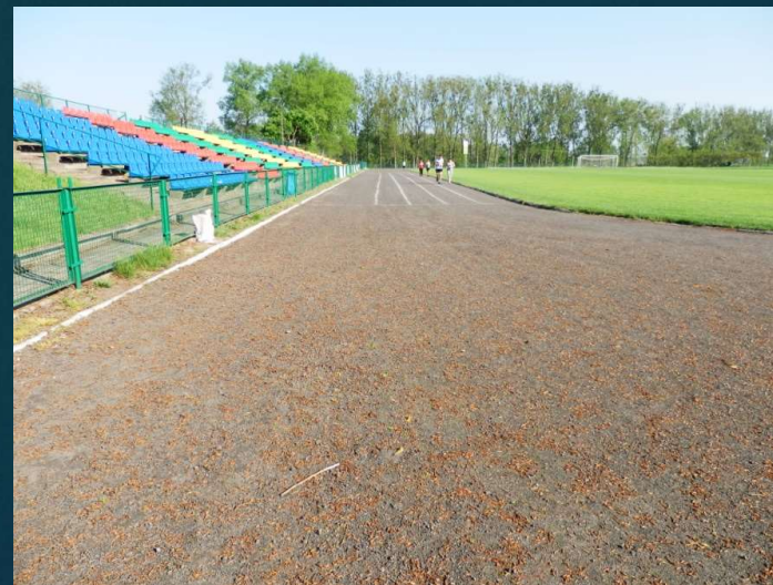
regeneracja bieżni stadionu wraz z utwardzeniem
