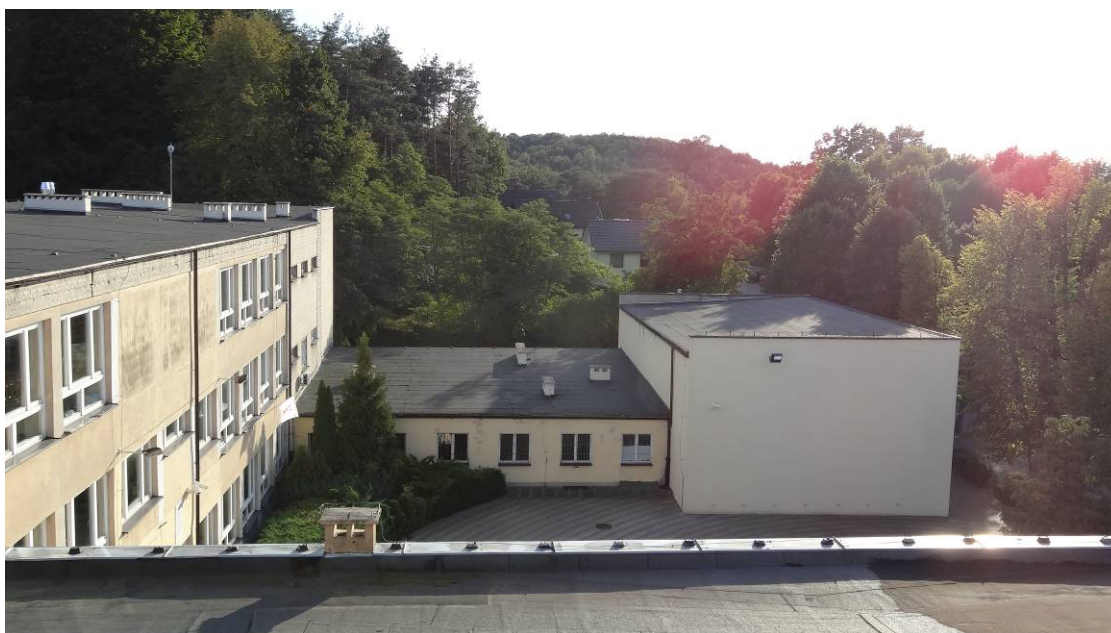
Fot.5 – Widok na dach łącznika i sali gimnastycznej (poza zakresem opracowania)
