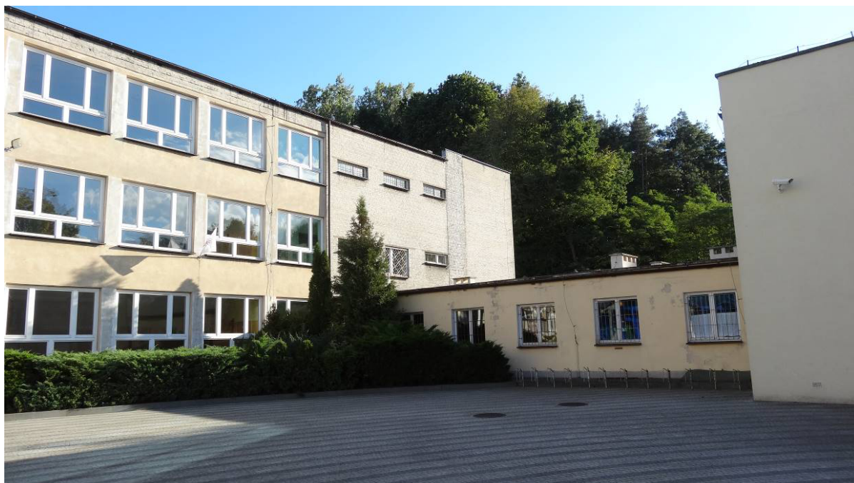
Fot.2 – Widok na budynek główny (poza zakresem opracowania) i łącznik od strony ulicy Wronieckiej
