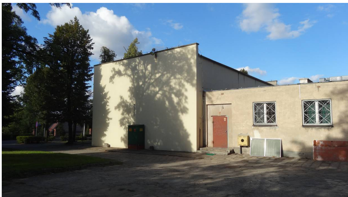
Fot.3 – Widok na budynek sali gimnastycznej (poza zakresem opracowania) i łącznik od strony wjazdu na teren boiska szkoły
