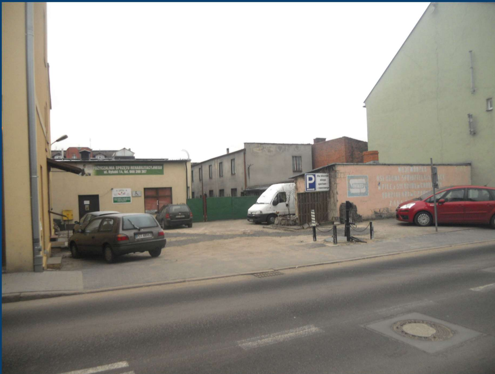
Rybaki 14 – przebudowano kanalizację sanitarną
