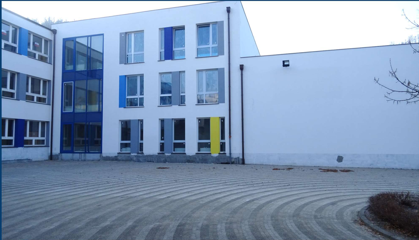
Rozbudowa budynku publicznego Szkoły Podstawowej nr 2.
