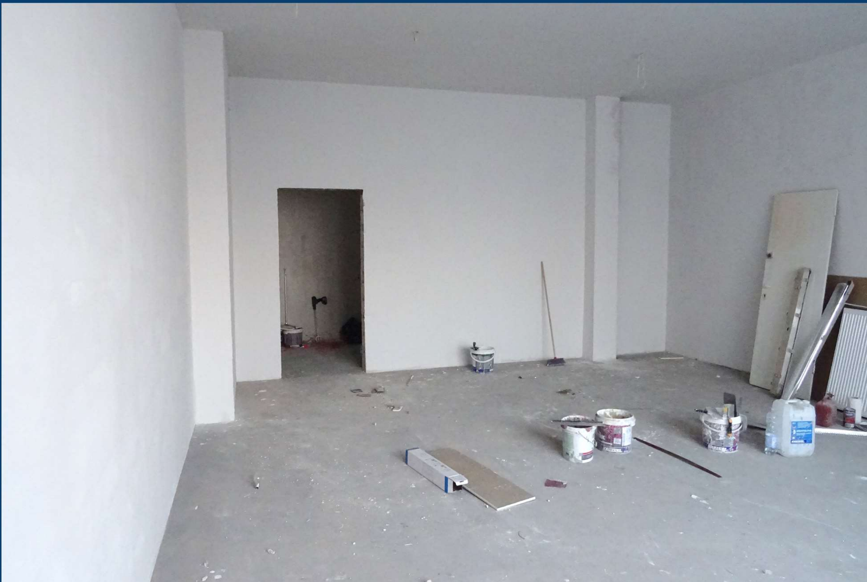
Rozbudowa budynku publicznego Szkoły Podstawowej nr 2.
