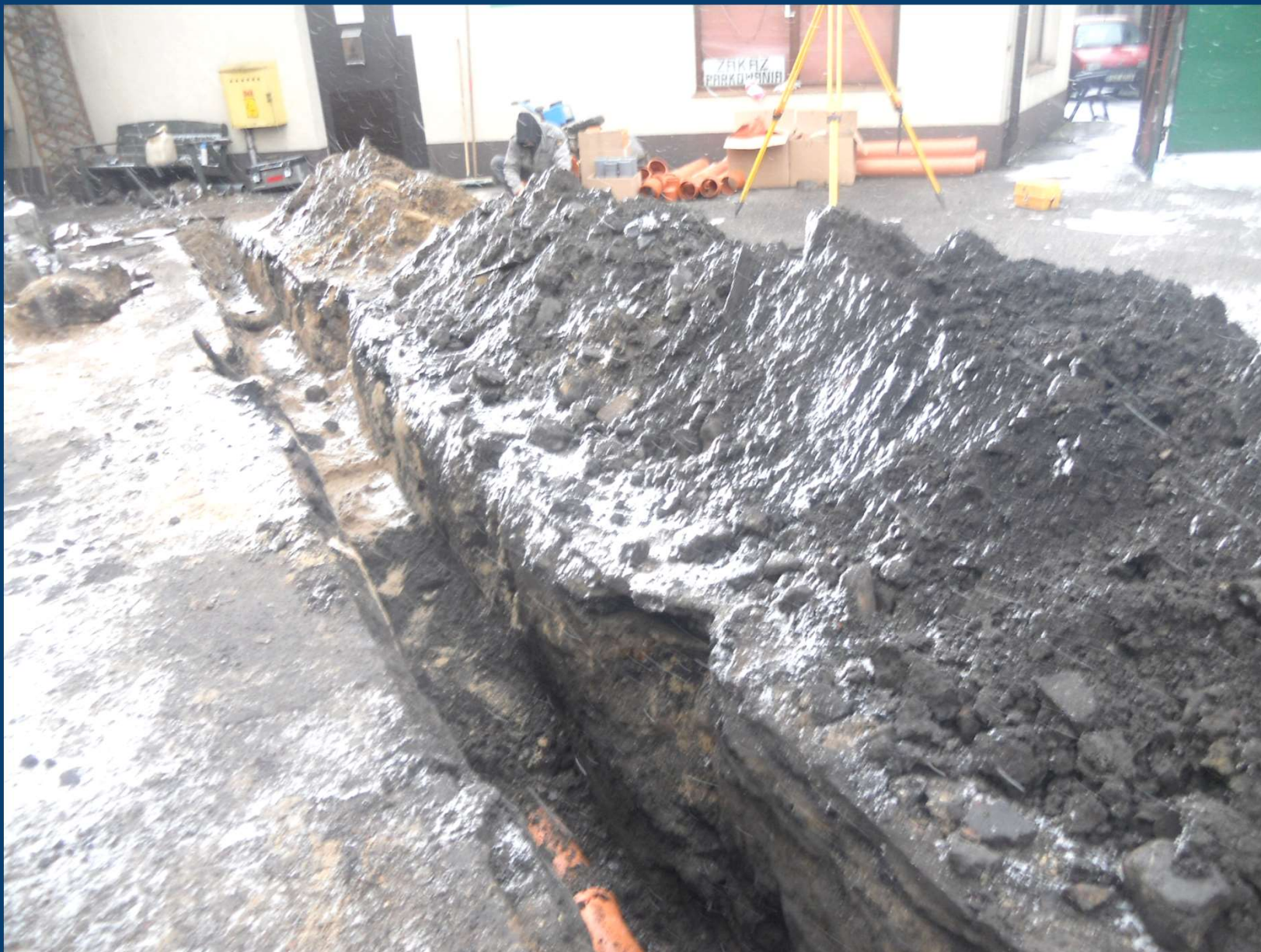
Rybaki 14 – przebudowano kanalizację sanitarną
