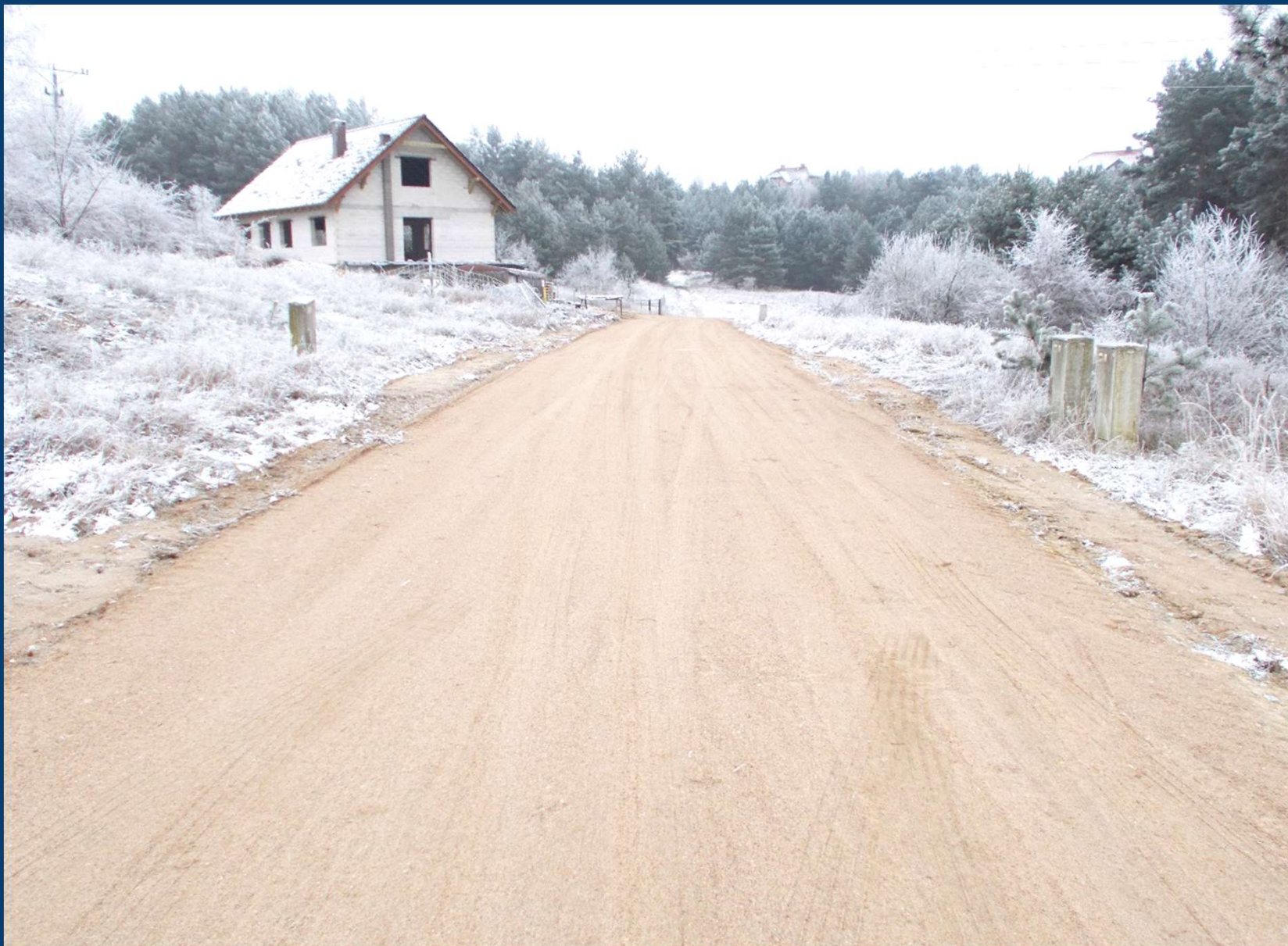
Remont nawierzchni gruntowej ul. Pułkownika Orłowskiego w Czarnkowie – po wykonaniu prac
