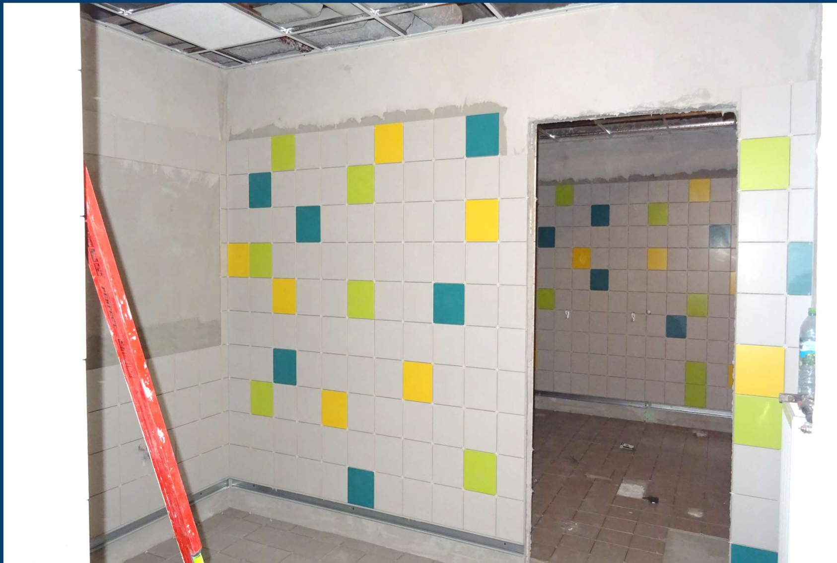
Rozbudowa budynku publicznego Szkoły Podstawowej nr 2.
