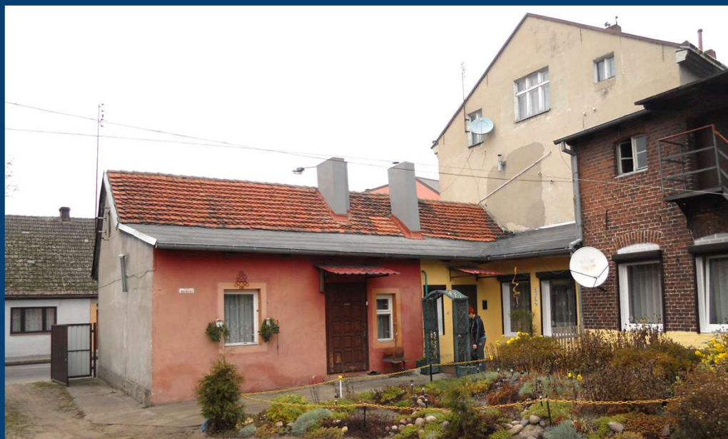
Kościuszki 68 - wymiana pokrycia dachu na budynku głównym – przed wymianą
